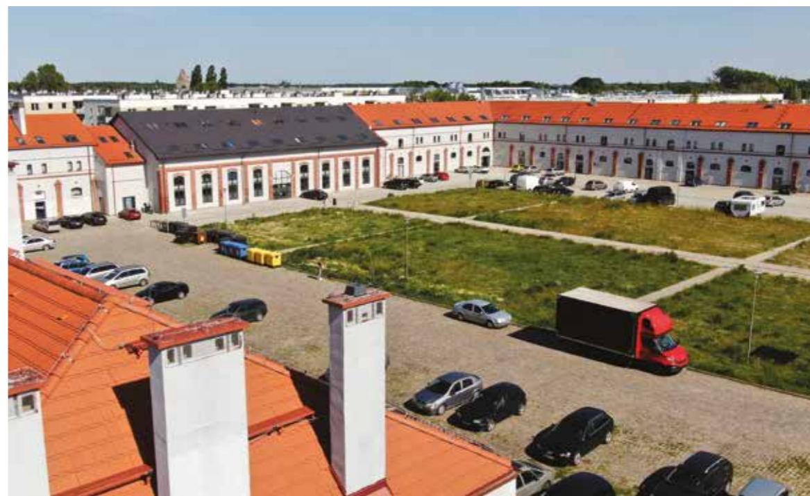
Rys. 4. Modernizacja zespołu stajni i ujeżdżalni na cele mieszkaniowo-usługowe, TBS Oława, realizacja 2019, projekt Arc-Hit. Obiekt o podwyższonym standardzie technologicznym poprzez zastosowanie wentylacji mechanicznej nawiewno-wywiewnej z rekuperacją i sufitowych mat kapilarnych do celów ogrzewania i chłodzenia pomieszczeń oraz pomp ciepła do przygotowania ciepłej wody użytkowej. Inwestycja współfinansowana przez BGK, nagrodzona w konkursie KfW Bauen w 2019 r.
